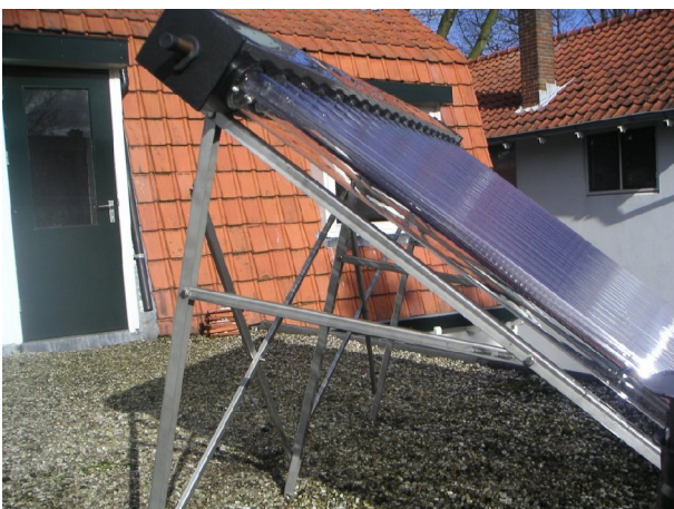
Afbeelding 5: Collector op steun.
